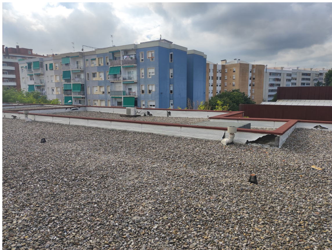
Coberta amb sectors independitzats per murets, xemeneies, boneres i làmines foradades. Unitat exterior de clima sobre palet de fusta
