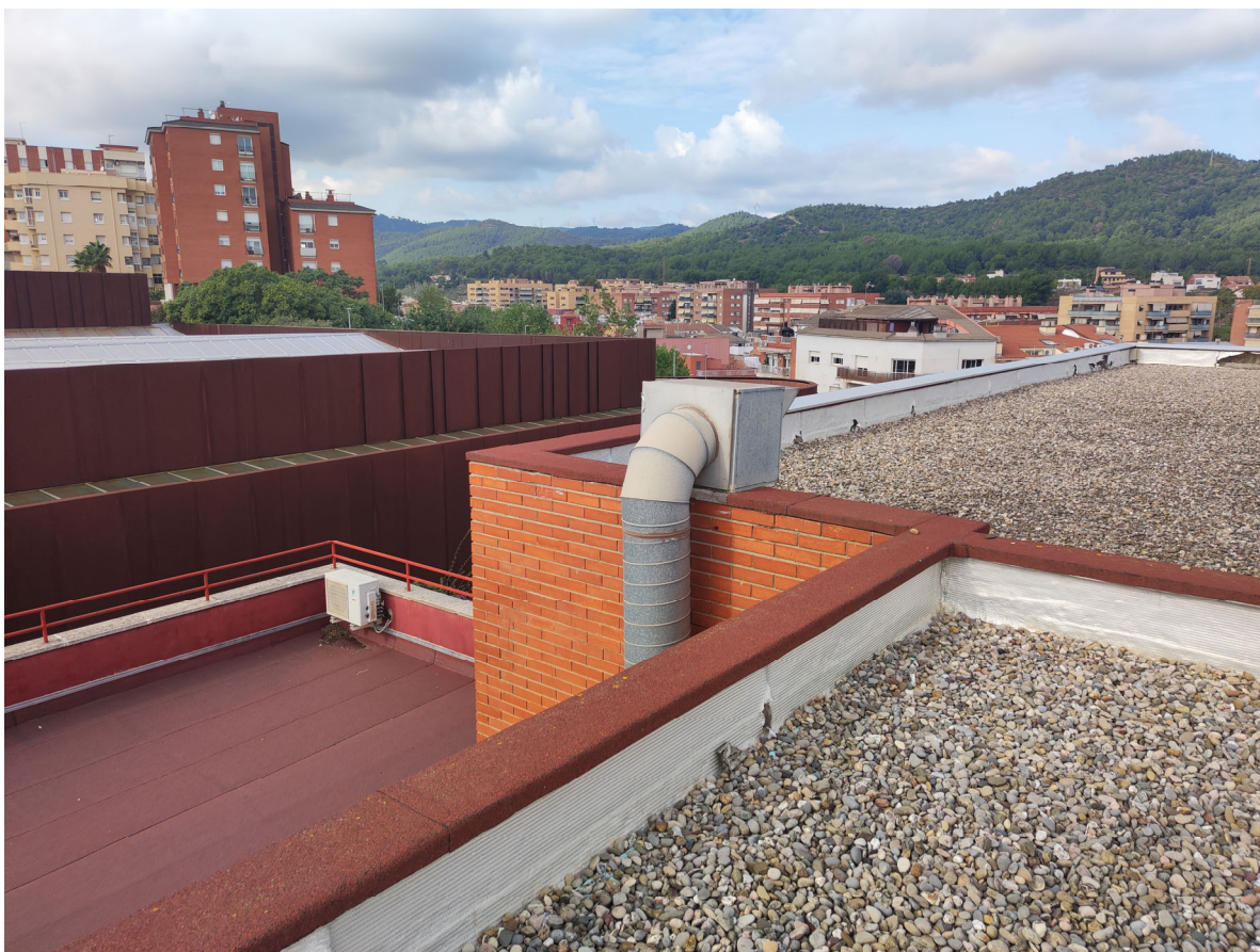
Sortida de bafs de la cuina amb motor sobre muret de coberta
