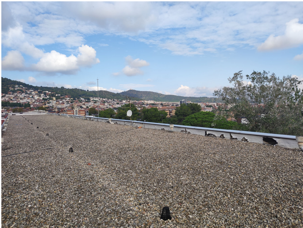
Vista general de la coberta. Xemeneies properes a façanes longitudinals i làmines foradades. Remat d'alumini de façana de SATE i boneres a tram central
