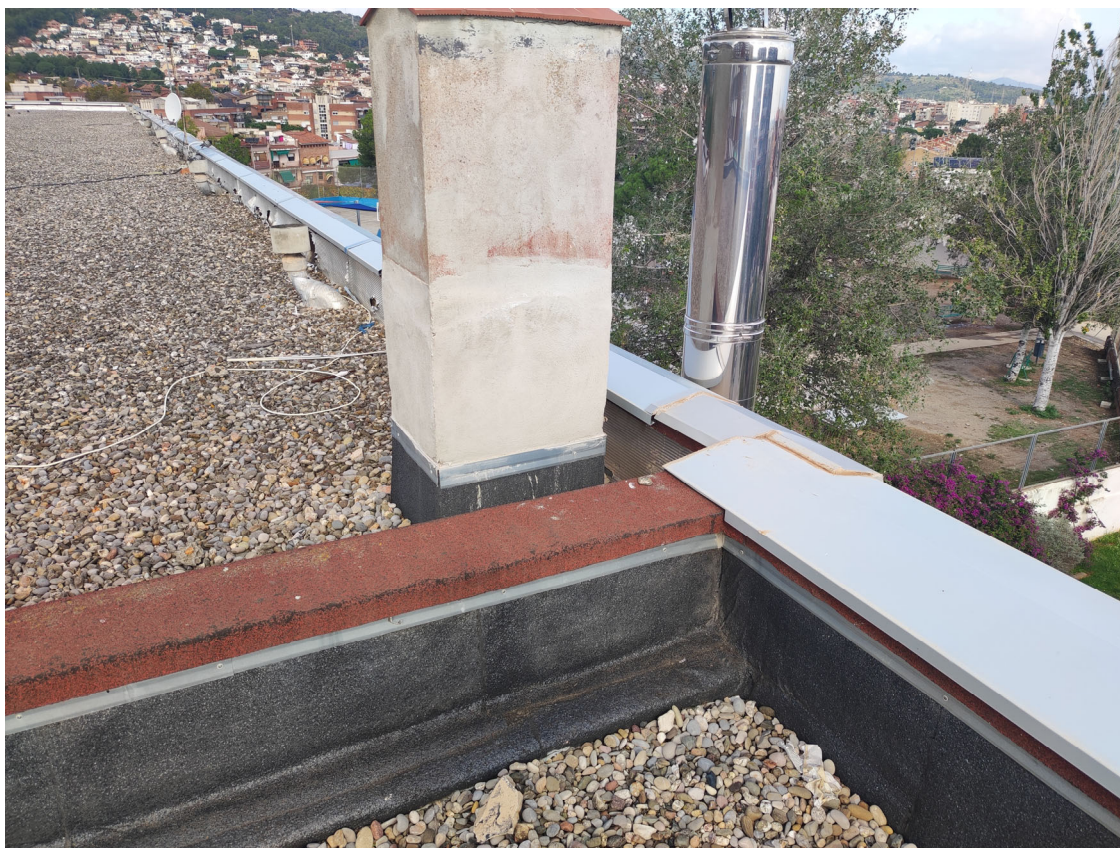
Xemeneia d'antiga ventilació de caldera, remats de façanes amb SATE i muret d'independització de sectors de coberta
