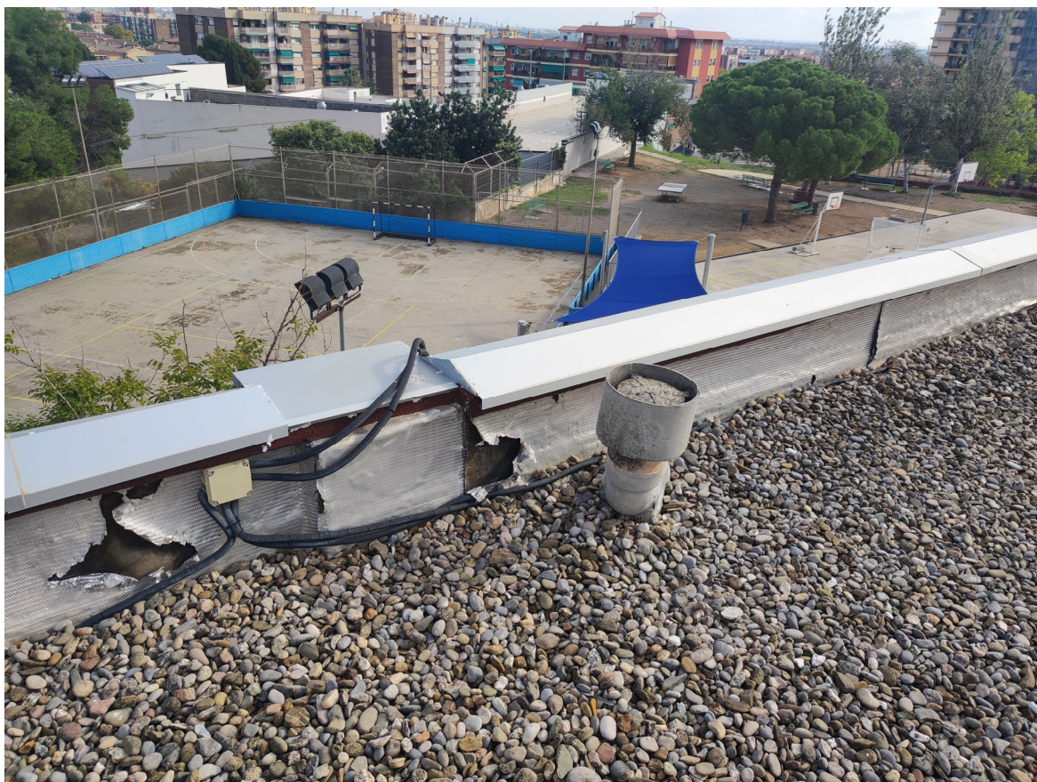
Detall xemeneia i remat de coberta amb façana amb SATE
